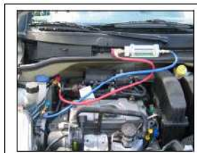
Szklany cylinder podłączony do klimatyzacji
